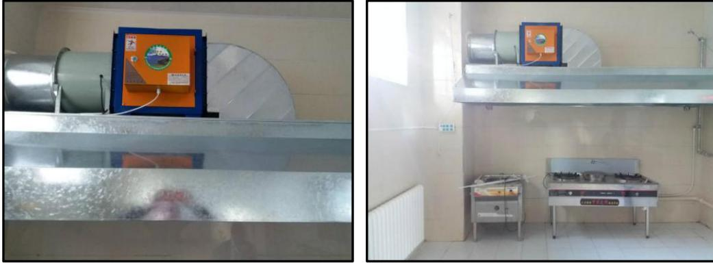
图 3-2 油烟净化器照片
